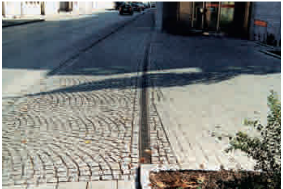
Abbildung 1: Entwässerungsrinne im öffentlichen Bereich.
