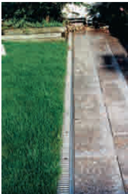
Abbildung 3: Entwässerungsrinne auf begrünten Dachflächen.
