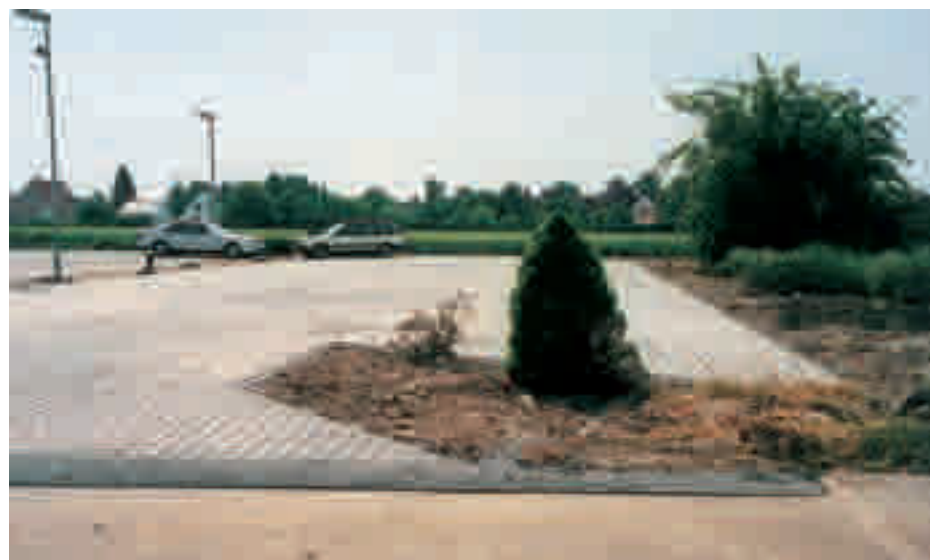
Abbildung 2: An eine Versickerungsmulde angeschlossene Verkehrsfläche aus Pflaster mit Sickeröffnungen.
