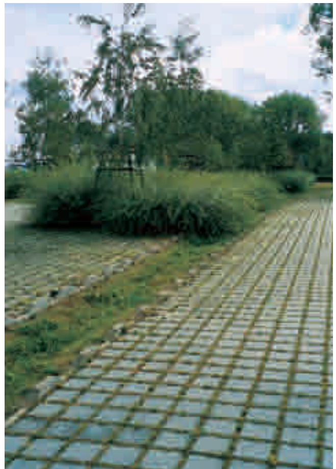
Abbildung 1: An eine Versickerungsmulde angeschlossene Verkehrsfläche aus Pflaster mit Rasenfugen.
