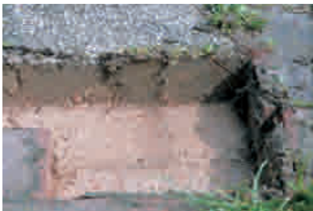
Abbildung 4: Anreicherung von mineralischen und organischen Feinteilen in Pflasterfugen im Laufe der Betriebsdauer. (Fotos: Verfasser).
