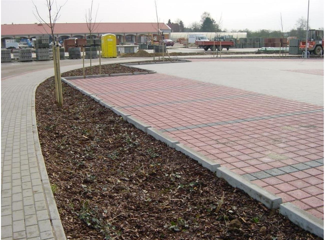
**Abbildung 3: Versickerungsfähige Pflasterbeläge mit Überlauf in Versickerungsmulde**
