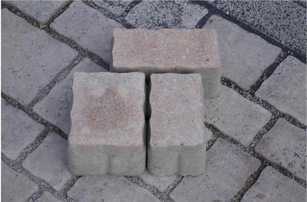
**Abbildung 23: Pflaster mit aufgeweiteten Fugen**
